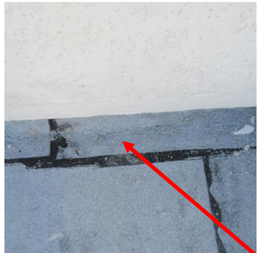
צוור 3 - תכנון מערכת איטום באזור הגבהה עם אף מים - מערכת איטום דו-שכבתית
